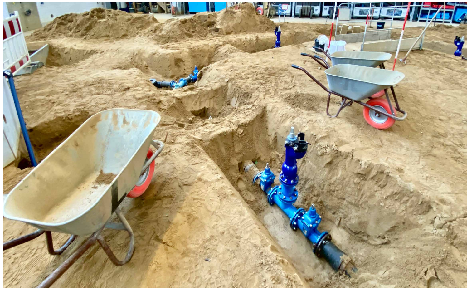
Rohrleitungsbau in der überbetrieb- lichen Berufsaus- bildung (Foto: Krümmel, TU Hamburg)
