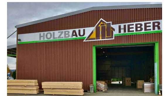
Werkhalle Heber Holzbau (Foto: Bau Bildung Sachsen e. V.)
